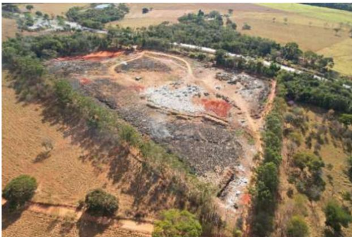
Figura 3 - Foto de satélite do lixão a céu aberto de Jaraguá/GO, em julho de 2024. Fonte: Plano de Recuperação de Área Degradada (PRAD) para encerramento do Lixão Municipal de Jaraguá (2024).
