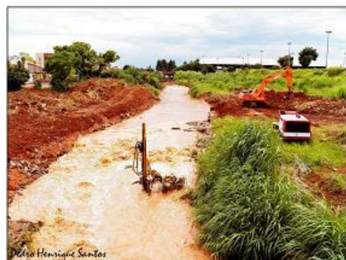
Figura 17. Obras de rebaixamento de parte do leito rochoso do ribeirão das Antas para aumento da profundidade do rio.
