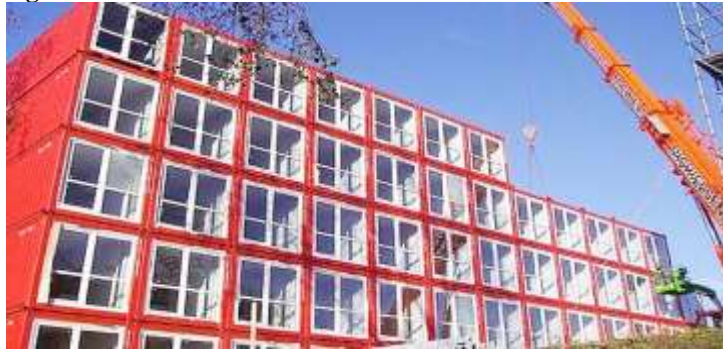
Figura 4 - Fachada do condomínio de estudantes Keetwonen .
